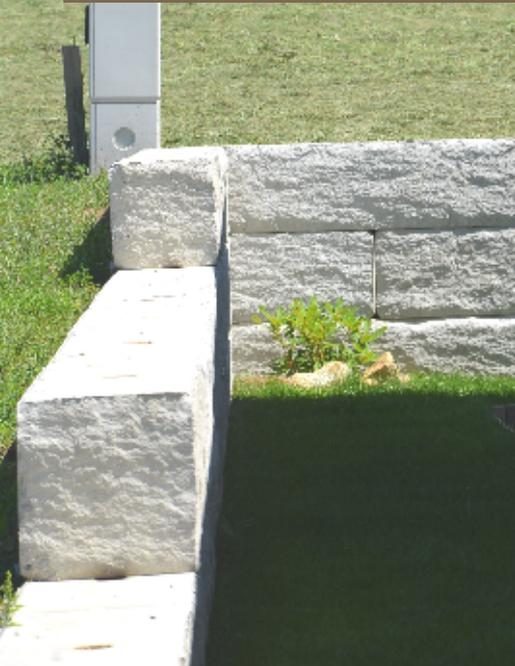
Aufbau einer CBLOCK Hangsicherung in Natursteinoptik - Abschluss mit Deckstein.
