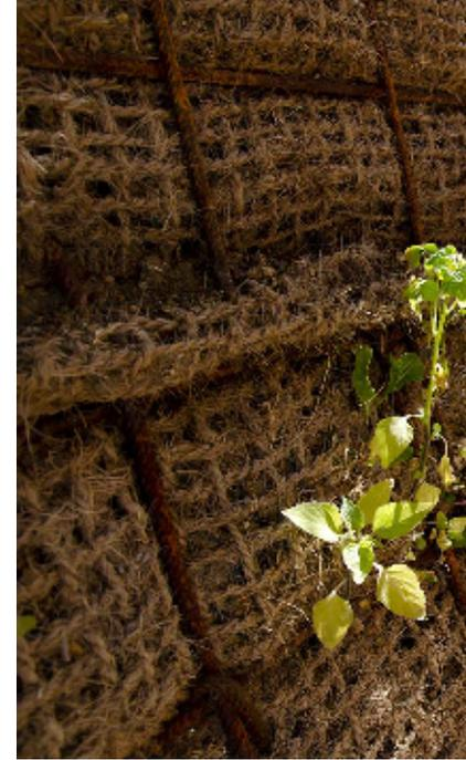
Bewehrte Erde ist eine kostengünstige Alternative für Steilböschungen bis zu 80°. Im engeren Sinne wird unter „Bewehrter Erde“ eine Form von Stützbauwerken verstanden, die ihre Anfänge in den 1960er Jahren fand.
