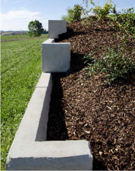
Aufbau einer CBLOCK Hangsicherung in Natursteinoptik Abschluss mit L-Stein:
